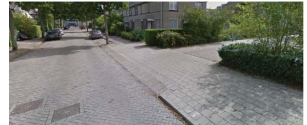
Inritconstructie op de overgang buurtstraat naar erftoegangsweg (Rietzangerweg met Kolgans).
