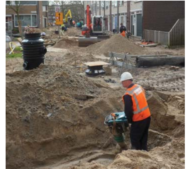
Voorbeeld werkzaamheden opknapbeurt riolering in de wijk Ruimzicht.
